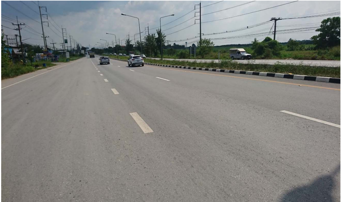
ภาพที่ 3.1 รูปภายหลังจากบูรณะทางหลวงหมายเลข 344 ตอน อ.บ้านบึง – อ.แกลง กม. 32+ 600 LT
