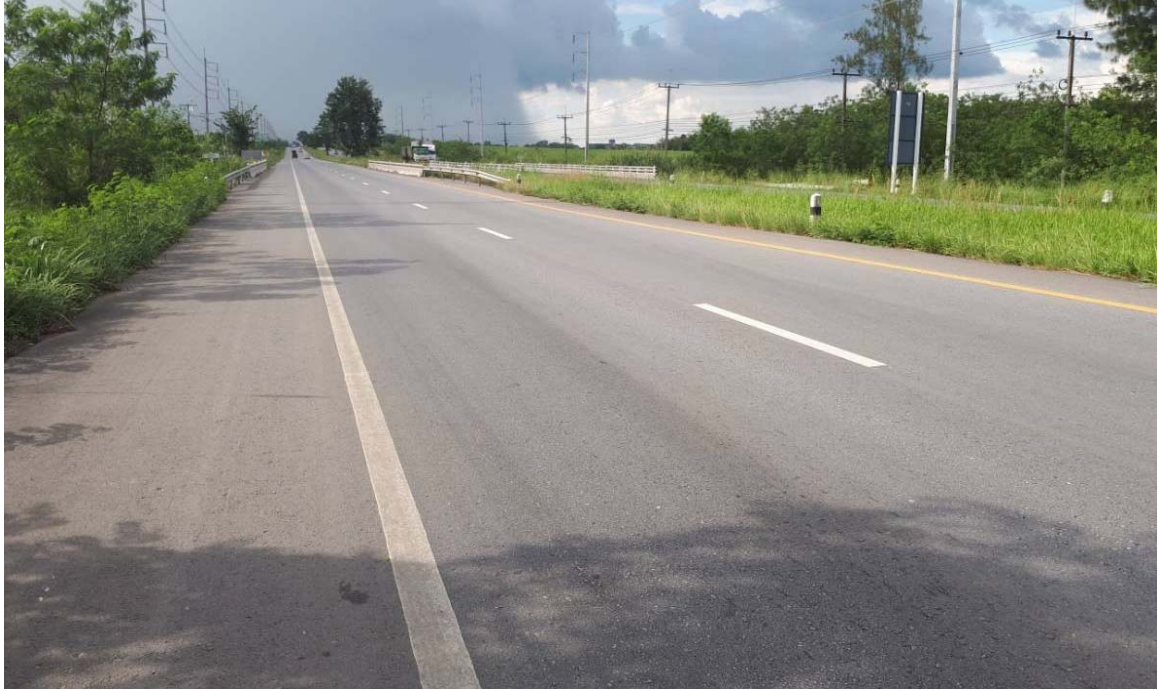
ภาพที่ 3.3 รูปภายหลังจากบูรณะทางหลวงหมายเลข 344 ตอน อ.บ้านบึง – อ.แกลง กม. 37+ 800 RT
