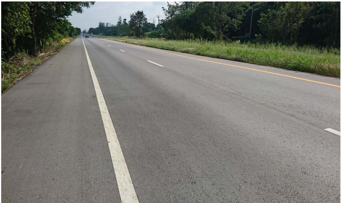
ภาพที่ 3.2 รูปภายหลังจากบูรณะทางหลวงหมายเลข 344 ตอน อ.บ้านบึง – อ.แกลง กม. 55+ 000 LT
